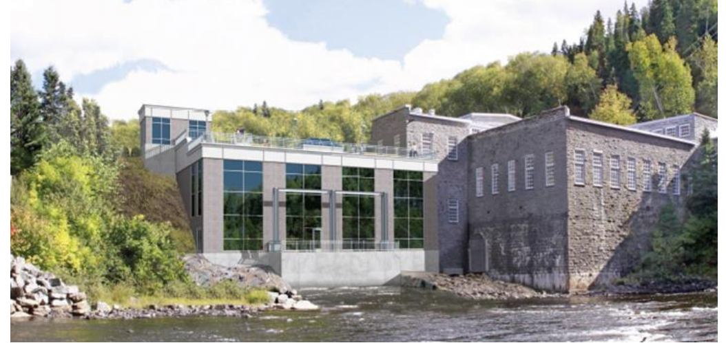
Modification de la centrale
