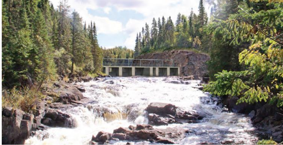
Modification du barrage
